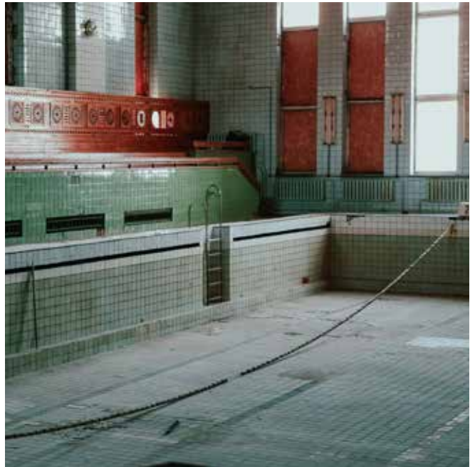
Foto © envato.com | DavePrimov
